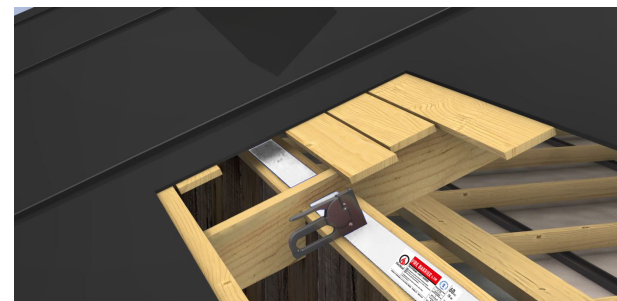
Skär av brandstoppet till passande längd. Bandet skall passa snävt mellan takstolarna. Häfta, skruva eller spika fast brandstoppet med 4 fästelement per meter
