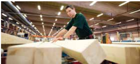
Tillverkning av limträpelare.
