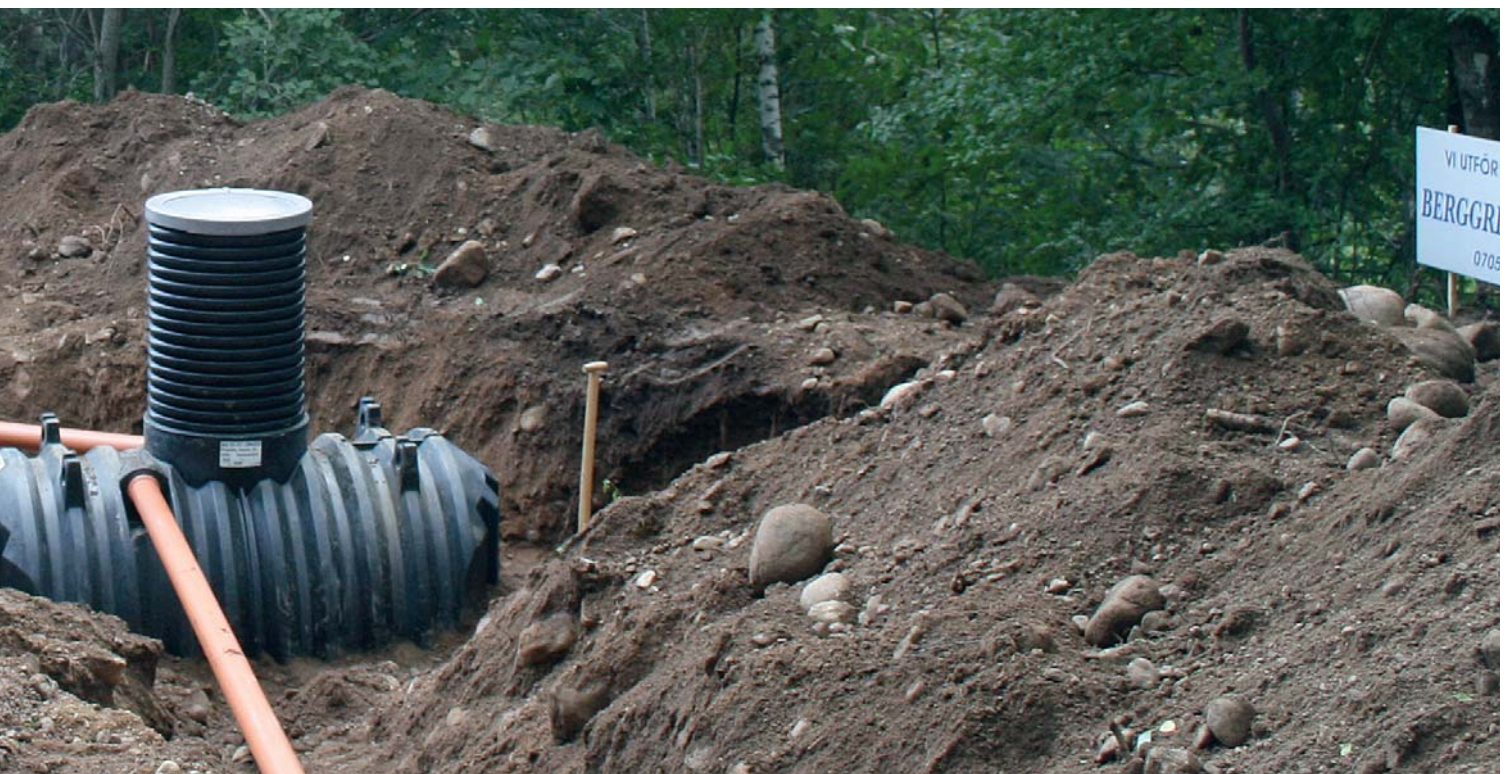
Septic III Compact infiltration med markbädd och kompletterande fosforrening
