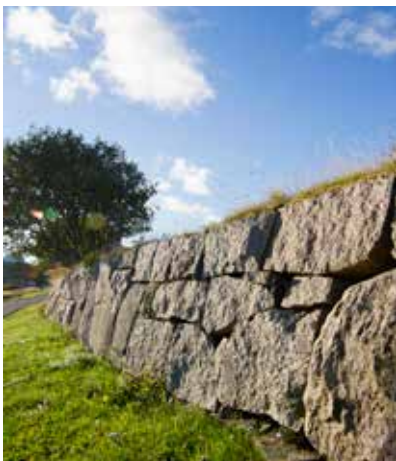
KRYSSMUR MED REJÄLA BLOCK OCH STORA FOGAR SOM GER ETT RUSTIKT INTRYCK
