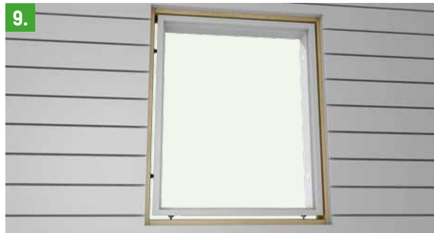
9. Isolera spalten mellan vägg och karm med Fogsukum Flex Pro, alternativt isolera med glasull.
