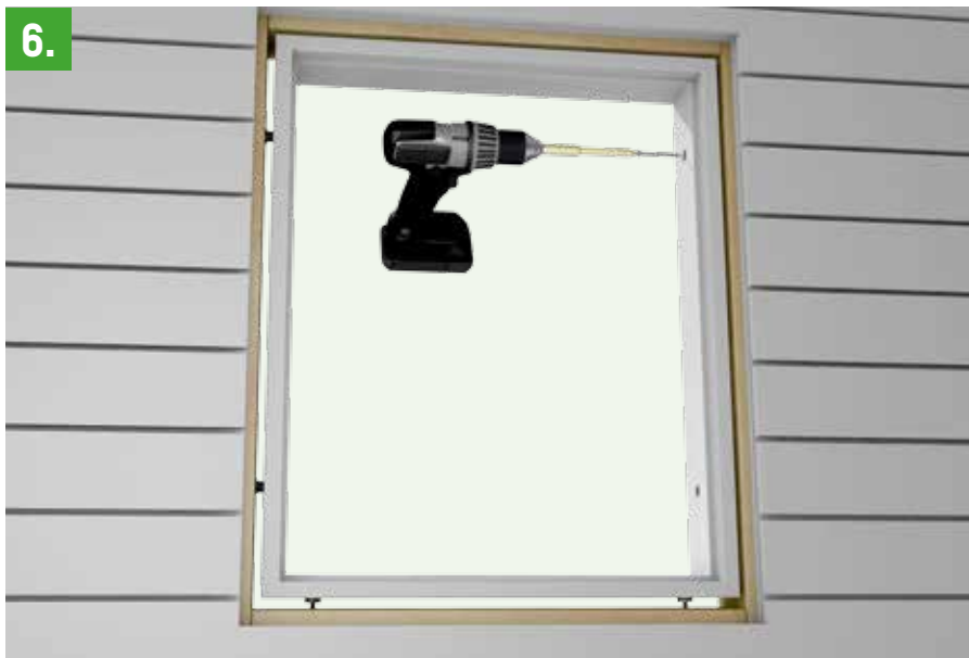
6. Betong och tegel måste förborras med 6mm borrh. Borrningen sker genom hylsan in i väggen.
