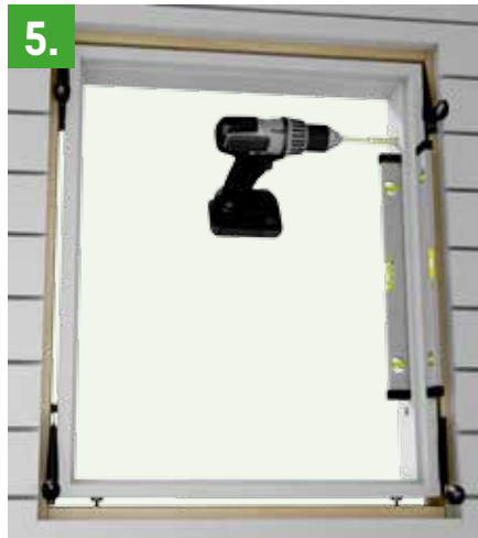
5. Fortsätt med de två övre hylsorna. Kontrollera med vattenpass att allt är rakt.
