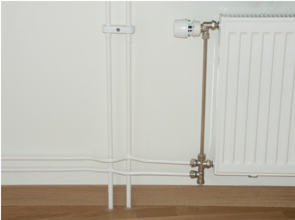
Vitmålade radiatorrör, Cupori 110 Premium, med platstillverkade rördelar för lödning
