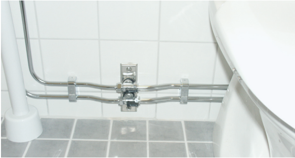
Förkromade kopparrör Cupori 120 (Chrome), R250, monterade i hygienrum
