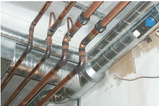
Raka hårda kopparrör, Cupori 110 Premium, monterade mot tak
