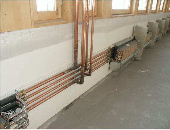
Hårda kopparrör, Cupori 110 Premium, med fabriksstillverkade kapillärrördelar och klämringsskopplingar
