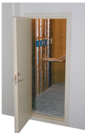
Exempel på öppet rörschakt
