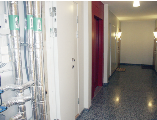
Schakt i trapphus
