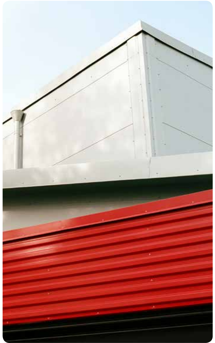
Plannja 45. Liggande, röd Plannja 45 profil. Intressant takavvattningslösning som med sina vattenkupor kastar tillbakablickar i kontrast till den moderna plåtfasaden.
