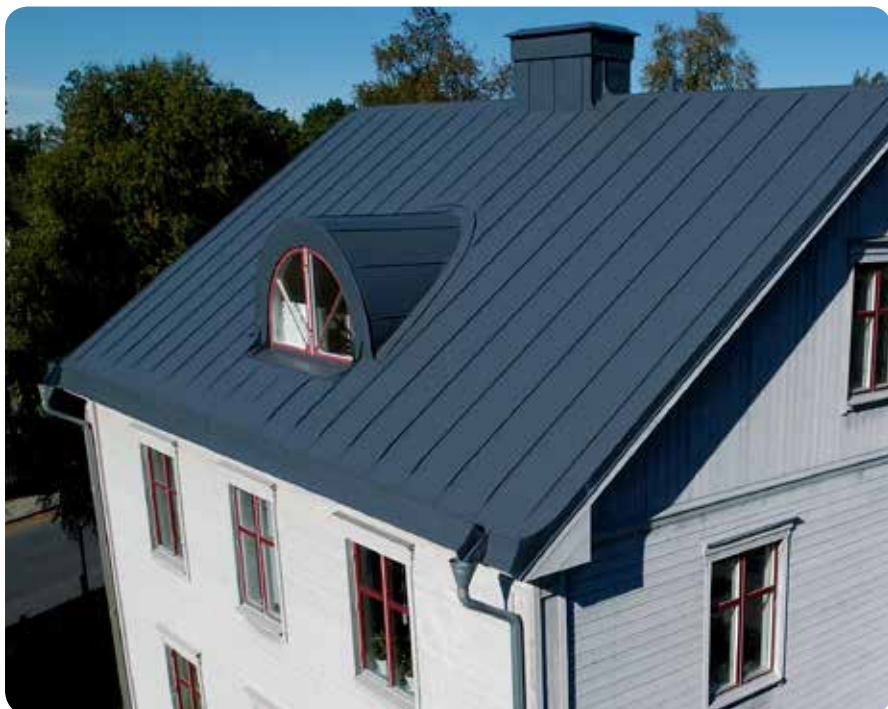
Större villa som fått ett nytt klassiskt bandtäckt plåttak i mörkgrå kulör som harmonierar med fasadens ljusare grå ton. Takavvattning ur Plannjas sortiment "Tradition" som passar lite äldre fastigheter allra bäst.
